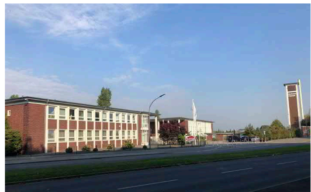
Bild 11.3 – Eingangsbereich der ehem. Kokerei Hassel (Quelle: Bezirksregierung Arnsberg)
