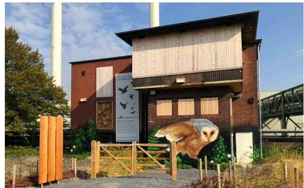
Bild 11.4 – Fertiggestelltes „Artenschutzhaus“ Hassel (Quelle: Bezirksregierung Arnsberg)
