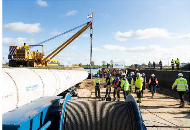
Bild 13.4 – Unterquerung des Rheins am 16.10.2019; Einzug des Dükerbauwerks (Quelle: Open Grid Europe GmbH)
