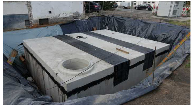
Bilder 9.9 und 9.10 – Fertiggestellte Betonierung der Bodenplatte, der Wände sowie des Drainagebauwerkes
