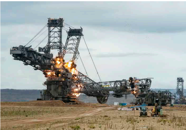
Bild 4.1 – Sprengung des Schaufelradbaggers 259 (Quelle: RWE Power AG)
