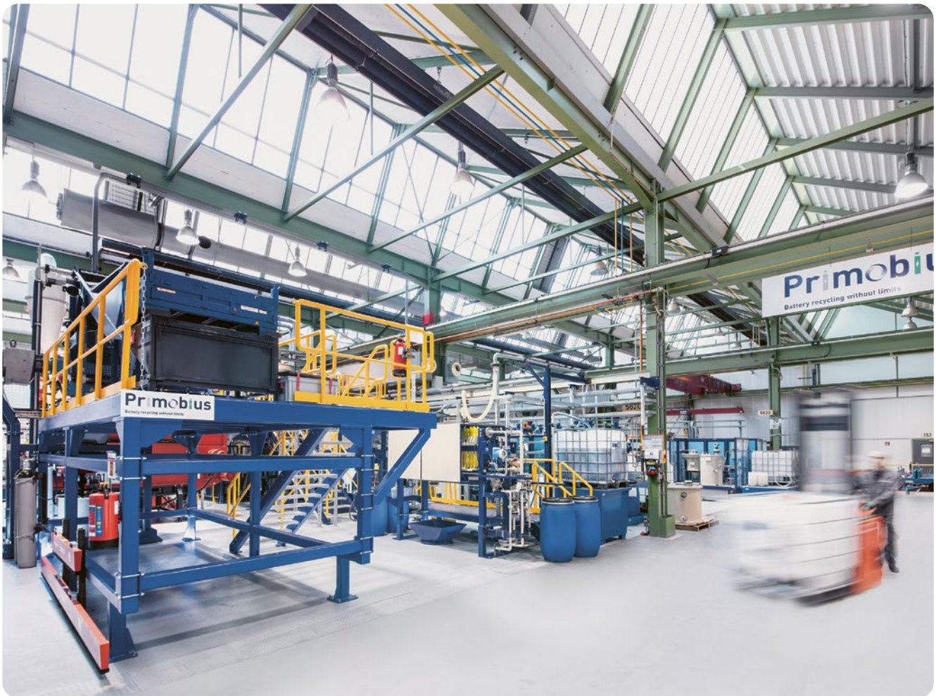
Hightech aus dem Siegerland: Primobius Recyclinganlage für Lithium-Ionen Batterien am SMS group Standort in Hilchenbach.
