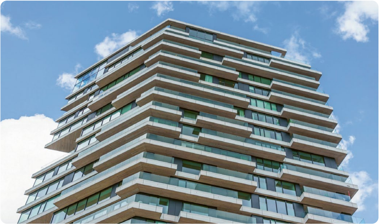
Der Wohnturm HAUT in Amsterdam zählt weltweit zu den höchsten Hochhäuser aus Holz. Für die hybride Bauweise aus Beton und Holz zeichnet die Münsteraner Brüninghoff Group verantwortlich.
