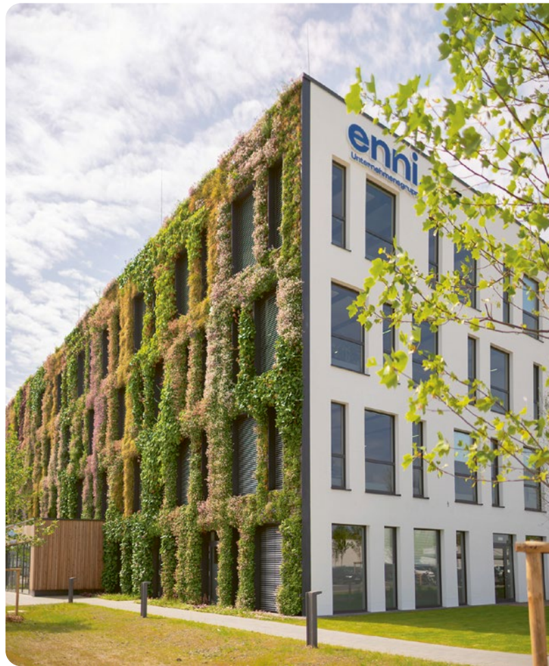
Bürogebäude mit innovativer Fassadenbegrünung in Moers
